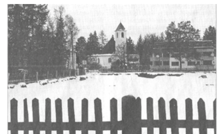
Bereits für den Baubeginn freiräumt ist das Grundstück an der Putzbrunner Straße. Durch freiwillige Grundabtretung des Bauherrn ist der Blick vom Rathaus zur Ottokirche wieder frei. Foto: Schunk
